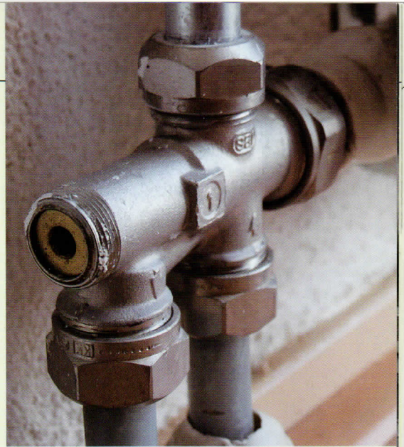
Land werkt het liefst met inregelbare (dubbelinstelbare) radiatorcransen; de voetventielen staan dan maximaal.
